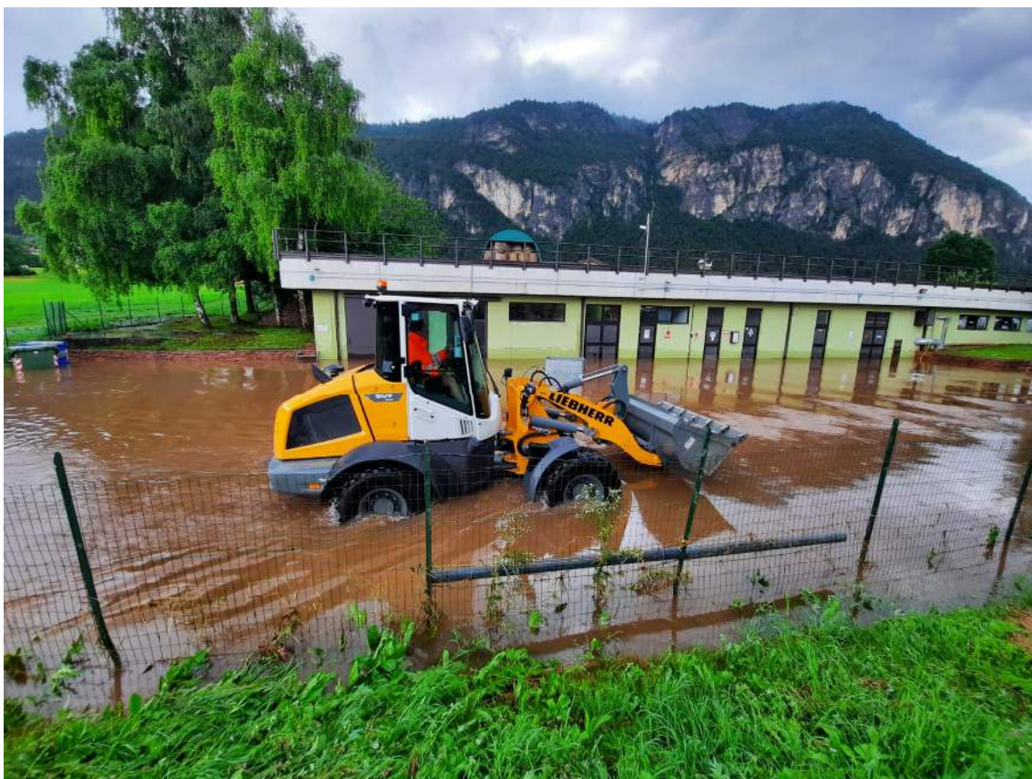
Foto 11 – depuratore allagato – operazioni di ripristino - luglio 2024
