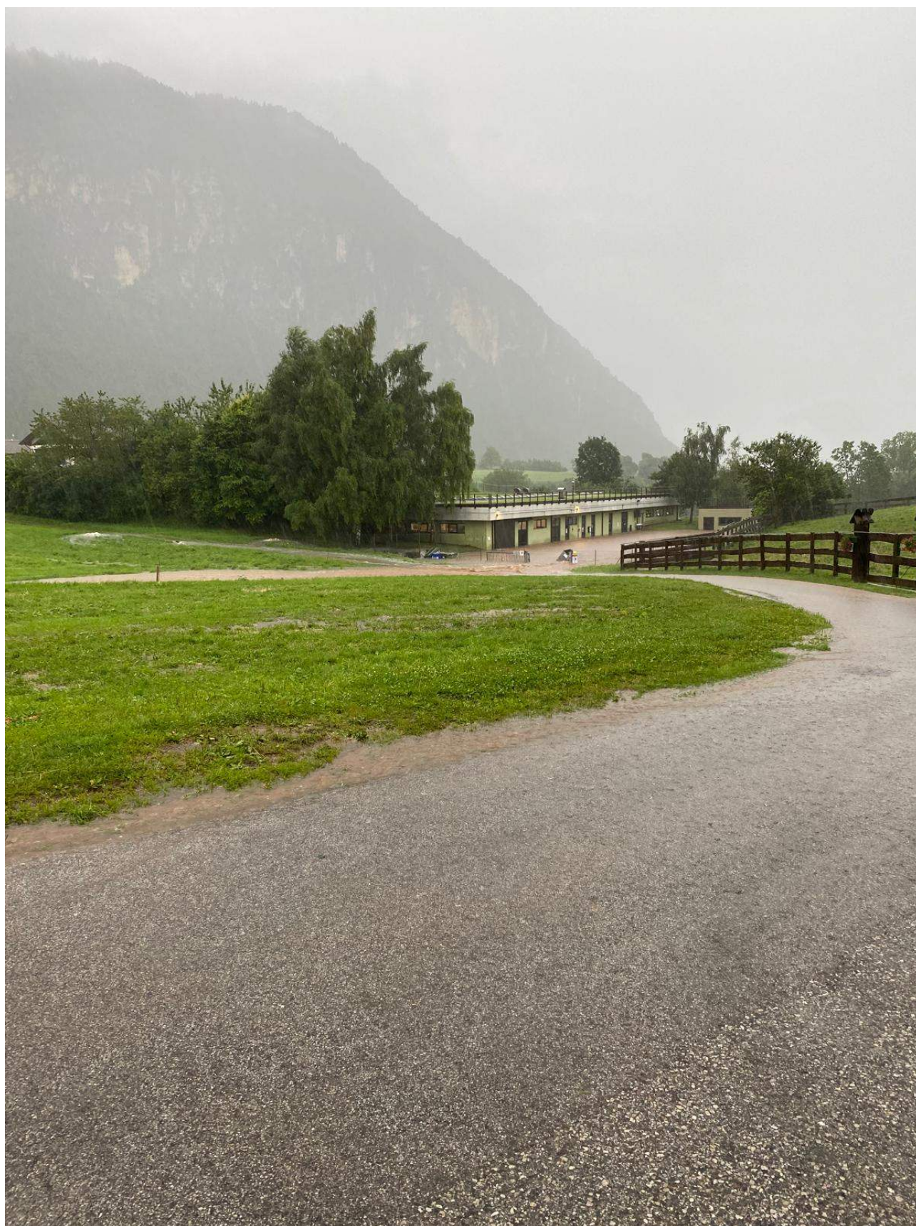
Foto 9 : depuratore visto da monte durante l'evento di luglio 2024 che ne ha causato l'ultimo allagamento. Si noti l'afflusso di acqua proveniente da strada e prati in corrispondenza dell'accesso al depuratore.
