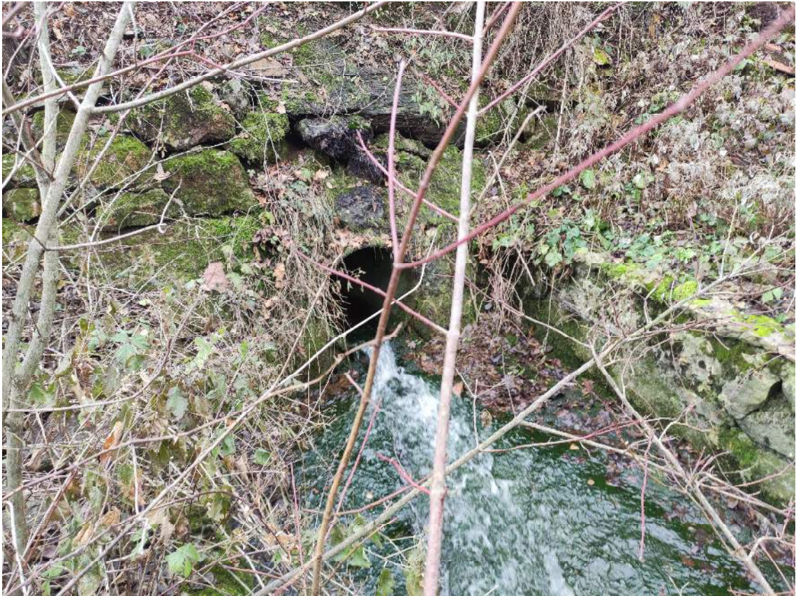
Foto 7 : terminale del tratto intubato del Rio Fai
