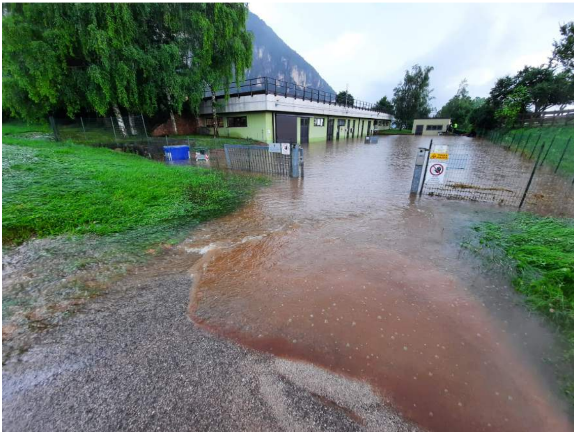
Foto 10 – depuratore allagato - luglio 2024
