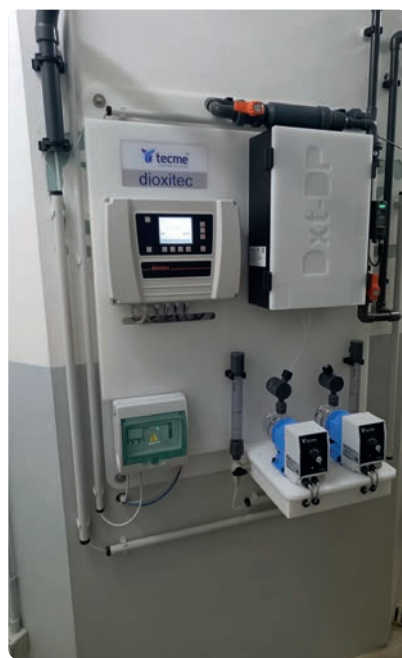
NUOVO LOCALE TECNICO
