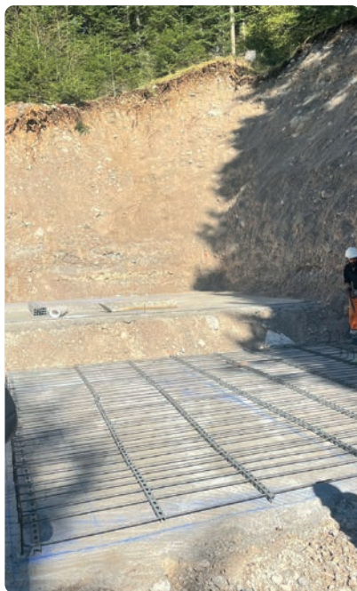
COSTRUZIONE VASCA LOC. AQUAI
